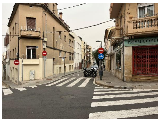
Imatge 16. Carre Juan de la Cierva amb carrer Pere Ponce de León, itinerari per a vianants ampliat amb orelles
