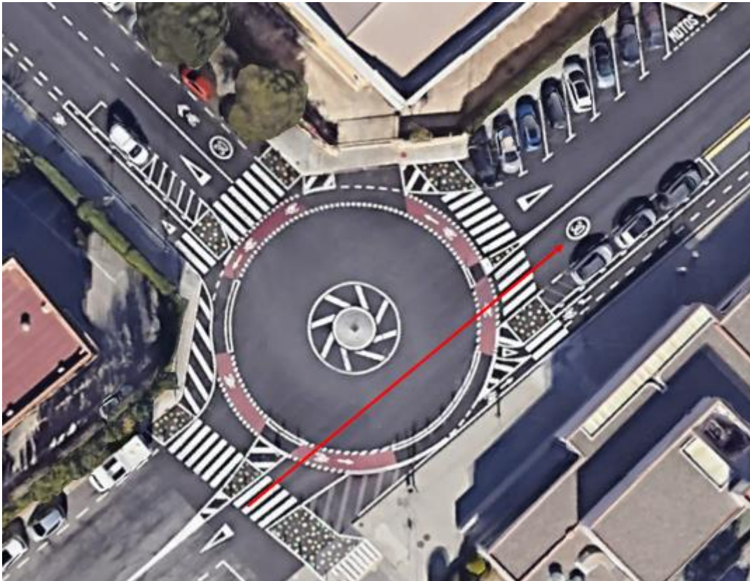
Figura 28. Disfuncions de la rotonda de la cruïlla del carrer Narcís Monturiol i carrer Ponce de León
