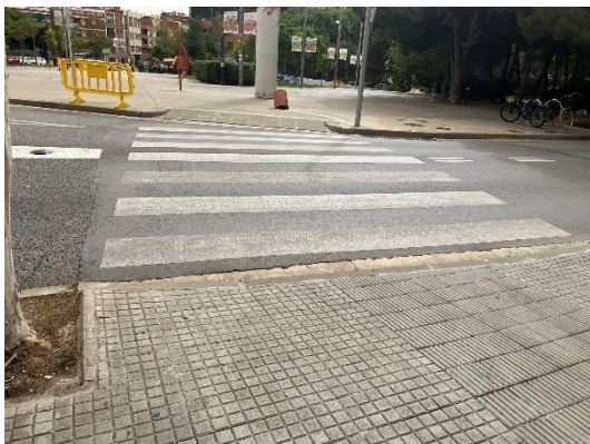
Imatge 12. Avinguda de la Indústria, pintura del pas de vianants desgastada
