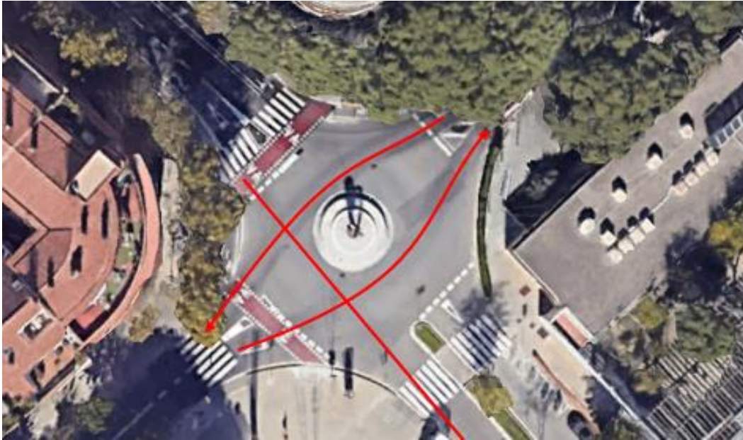
Figura 26. Disfuncions de la rotonda de la cruïlla de l'avinguda de la Indústria, carrer Ramon i Cajal i carrer Salvador Espriu
