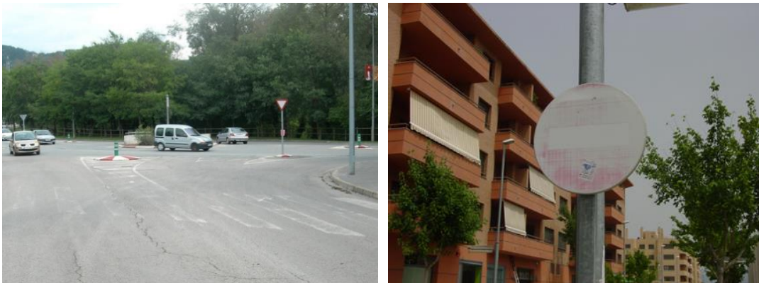
Imatge 67. Senyalització en estat deficient
