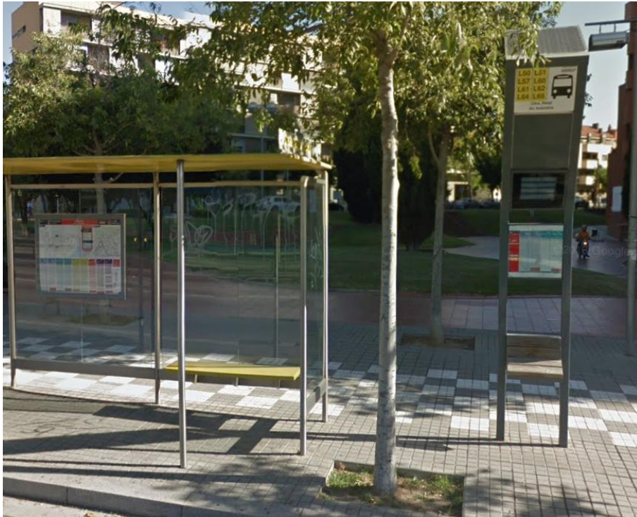
Figura 78. Marquesines a les parades de bus a la Carretera Reial
